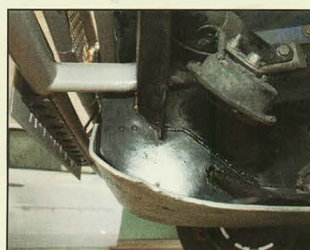
Des tôles ont été soudées au châssis afin de supporter la tôle de protection de la boîte. C'est du solide!
